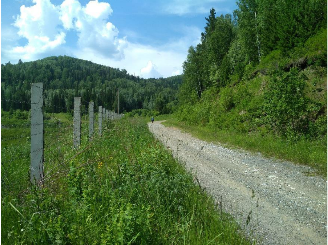
Рисунок 81. п. Нончхул. Начало подъема над тоннелем
