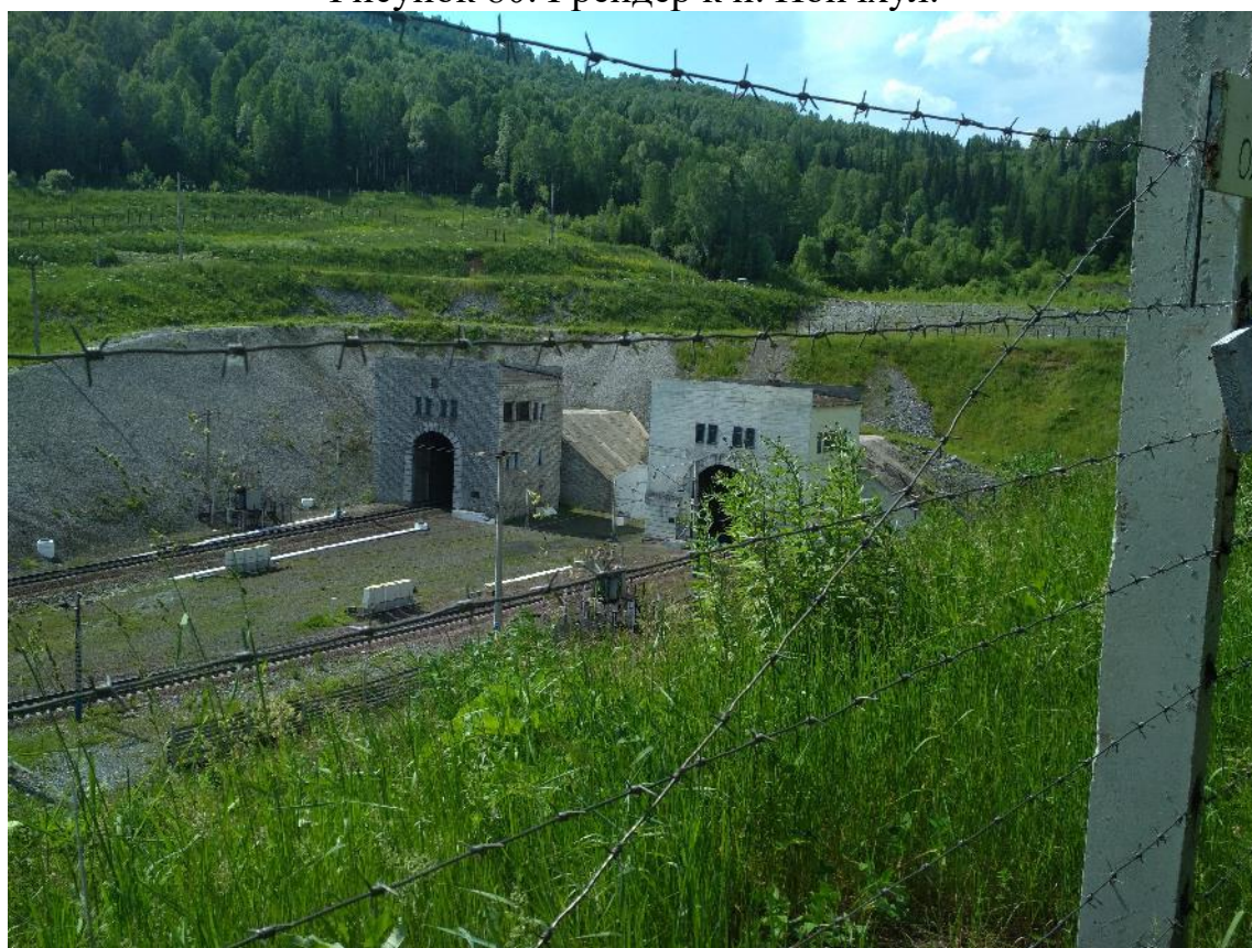
Рисунок 81. п. Нончхул. Восточный портал тоннеля
