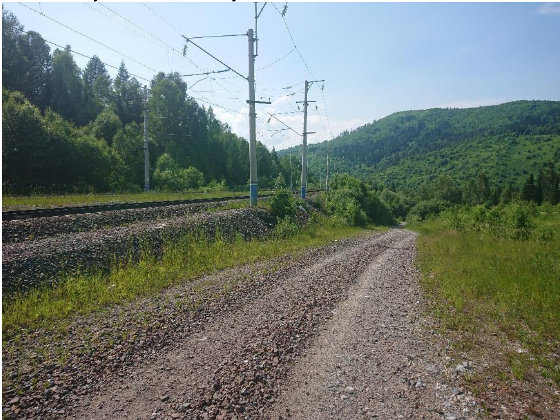
Рисунок 82. Спуск от западного портала тоннеля в сторону ст. Бискамжа
